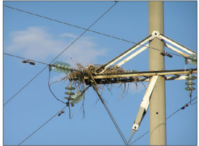
Гнездо могильника ( Aquila heliaca ) на ЛЭП. Фото И. Смельянского
