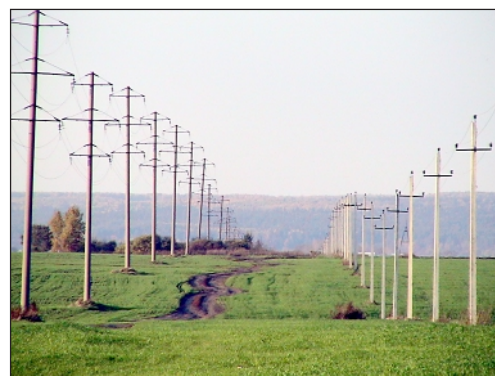
ЛЭП (6–10кВ) с железобетонными опорами в Нижегородской области. Фото А. Машыны
