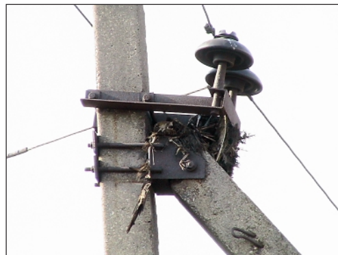
Птицеопасная опора с отпайкой и изоляторами. Фото А. Мацыны
