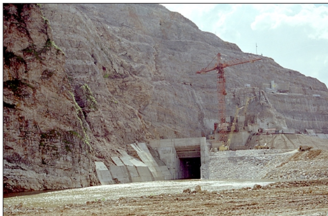
Строительство плотины Юмагузинского водохранилища. Фото А. Паженкова
